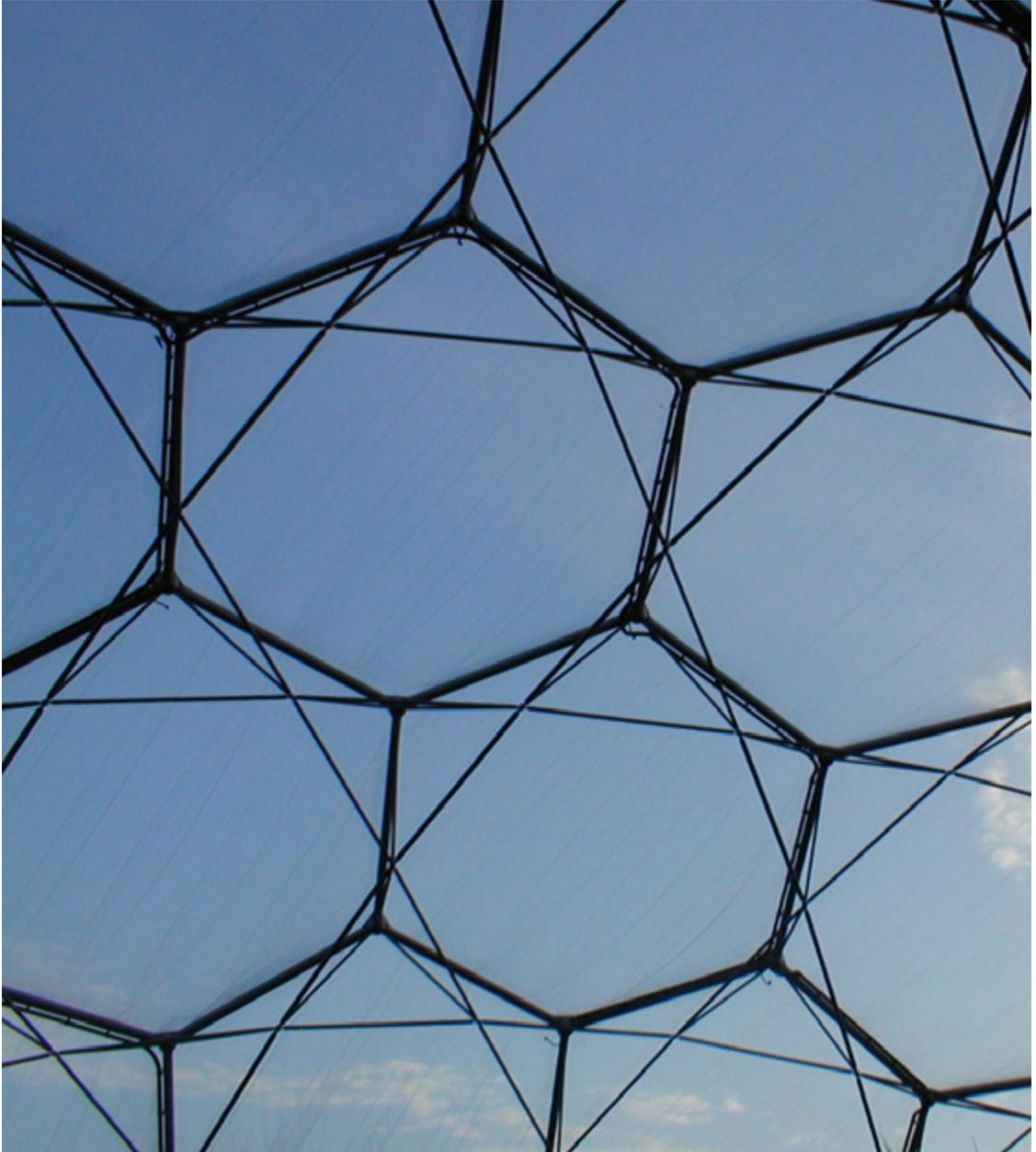
Estructura hexagonal vista desde dentro de la cúpula del New Alchemy del proyecto Edén
