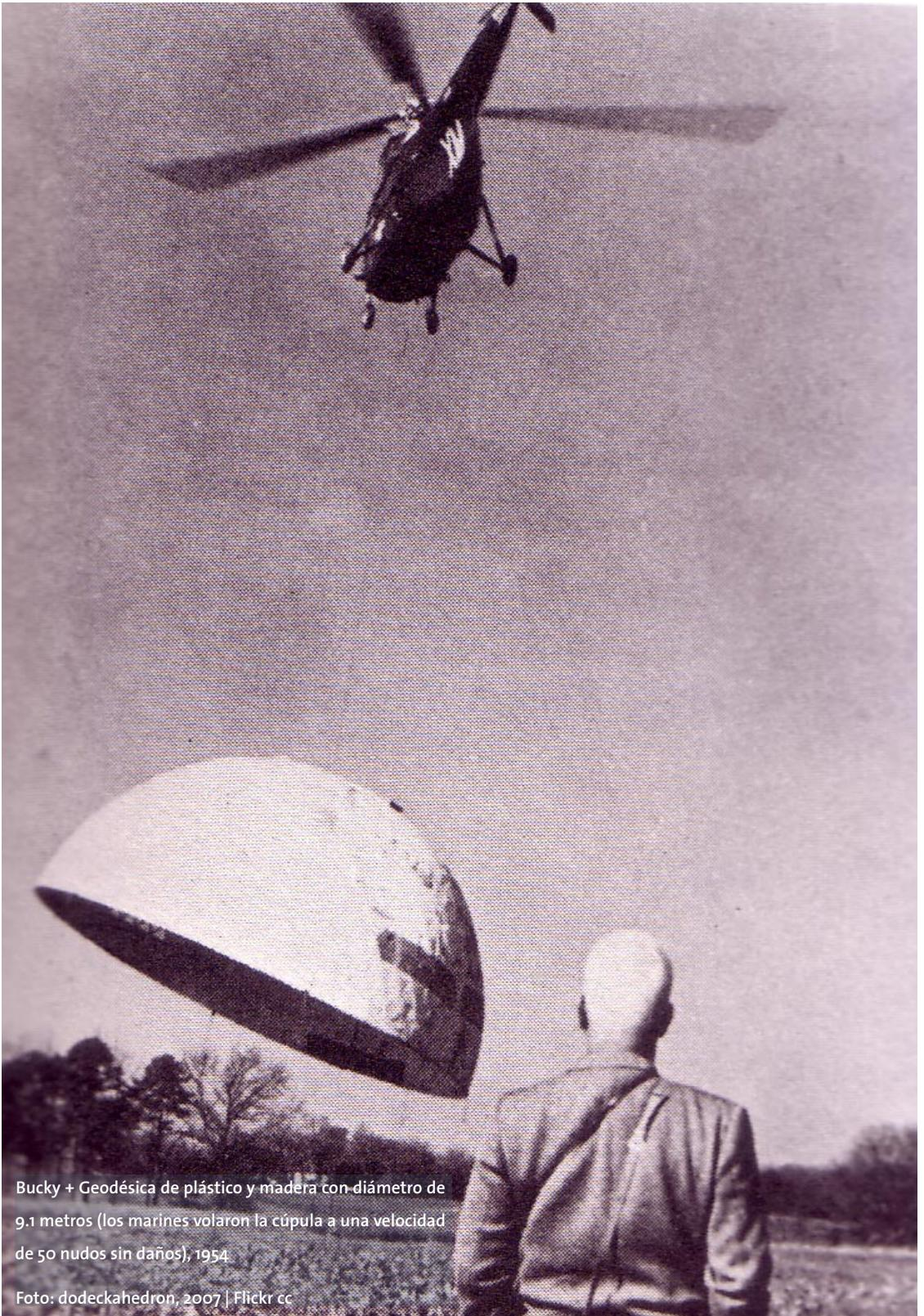
Bucky + Geodésica de plástico y madera con diámetro de 9.1 metros (los marines volaron la cúpula a una velocidad de 50 nudos sin daños), 1954
